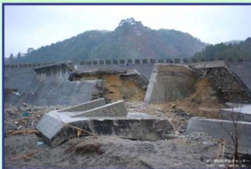
津波で破壊された防潮堤(岩手県宮古市田老地区)
