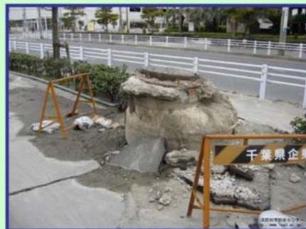
液状化によるマンホール被害(千葉県浦安市)
